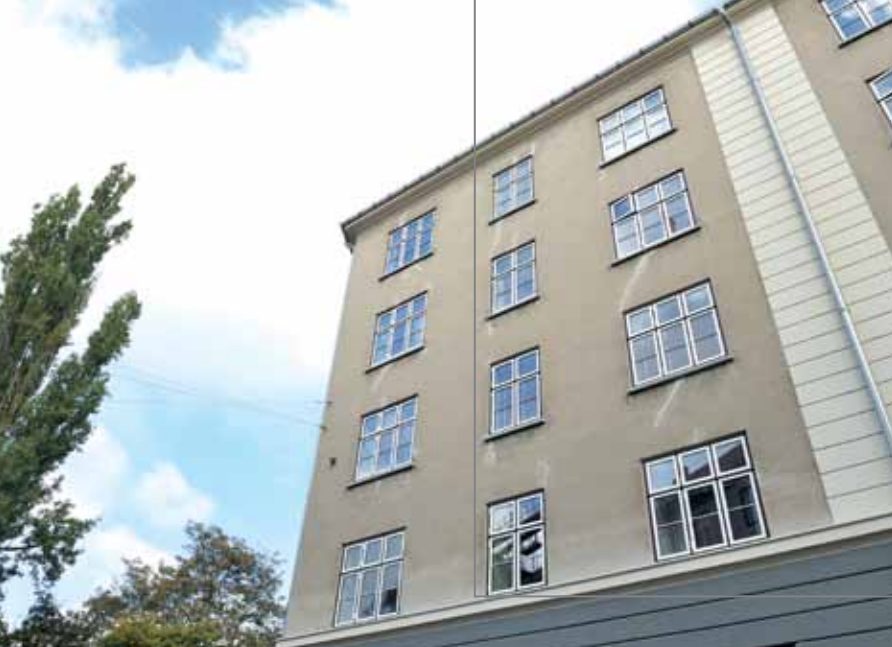
Stefansgade 40-46 mfl., København N. Udskiftning af cirka 1.000 vinduer.
